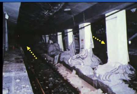
Daikai 駅 (振動より断層運動による破壊)
