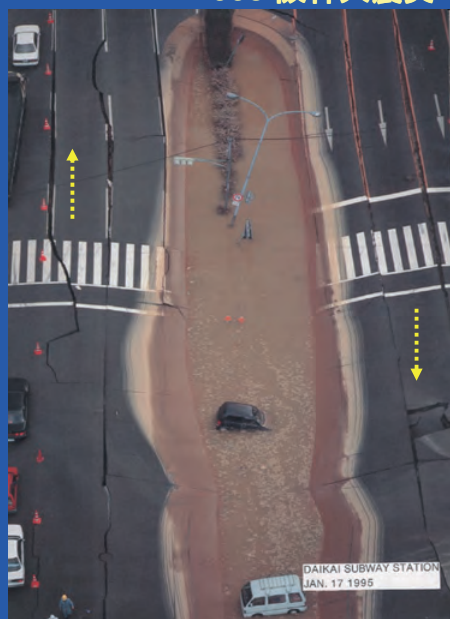
Daikai 駅 (振動より断層運動による破壊)
