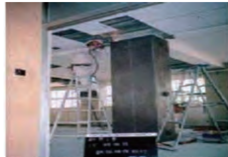
写真－2 鋼板巻き立て工法
