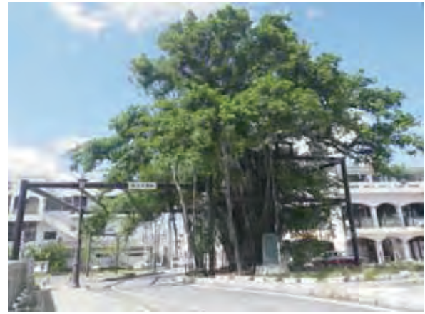
写真-3 倒木対策工 竣工状況
