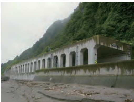
写真-1 RC製ロックシェッドの一例
