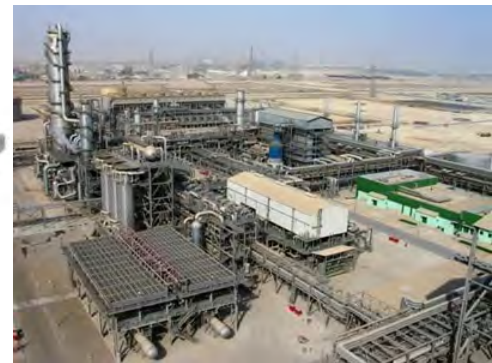
プラントのRC建屋
