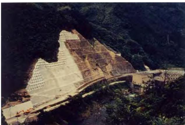
切土は1988年（昭和63年）2月に開始され、8段ののり面のうち最下段を切土中の1990年（平成2年）4月20日、モルタル吹付のクラックと2段目のり面の押し出しが発見された
