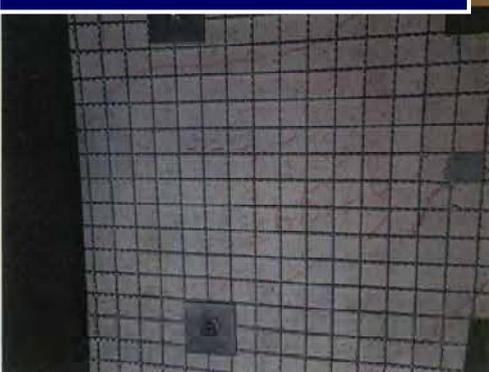
トンネル壁面の変状観測が可能な範囲で、網目の細かい25mmの金網を設置
