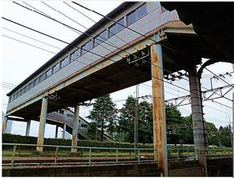
プッシュオーバー解析により橋脚の塑性箇所、変形性能、基礎の安定性、支承ボルト応力度、上部構造桁組みの応力度等を照査
