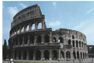
アーチのスパン( $l$ )に対する高さ( $h$ )の比( $h/l$ )をスパンライズ比という。スパンライズ比が小さいとアーチ広がろうとする軸力が大きくなる。一方、スパンライズ比が大きいと軸力でほとんどの外力に抵抗できるため構造的には安定的ではあるが、要求されるスパン長さを得るにはアーチのサイズが大きくなるため経済的に非効率的な構造になる。一般的に、経済性と構造的効率性を同時に考慮したスパンライズ比は約 0.3 といわれている。
