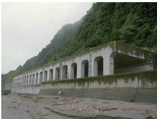
写真-1 RC製ロックシェッドの一例
