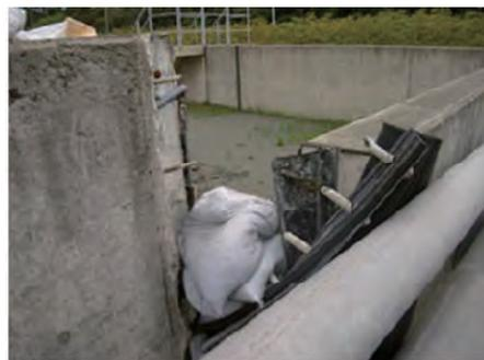
液状化による防油堤の破壊(2011年東北地方太平洋沖地震)
