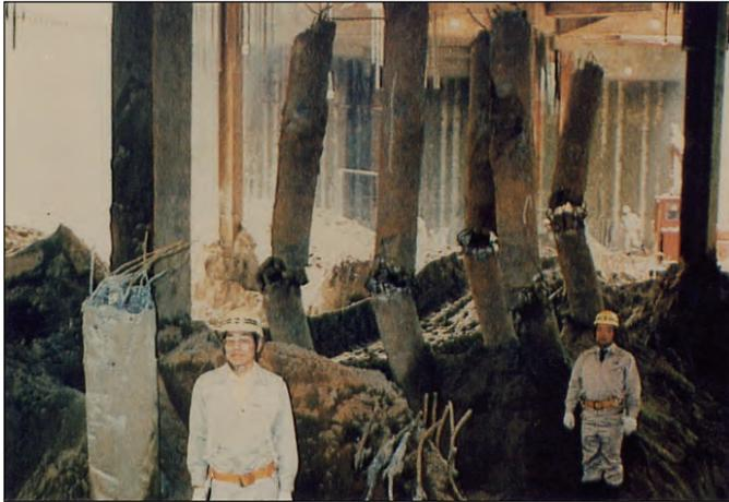
旧NHKビルのコンクリート杭の被害
