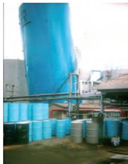
液状化によるタンクの傾斜・沈下(1995年兵庫県南部地震)
