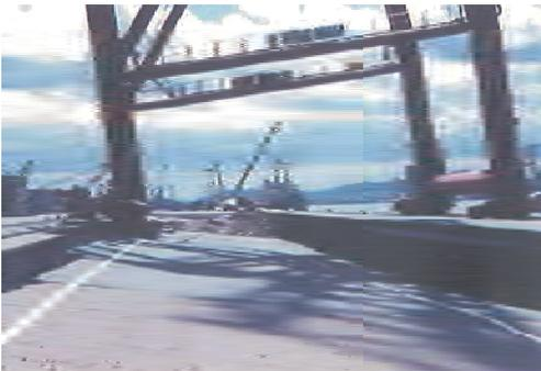
ガントリークレーンの傾斜と沈下
