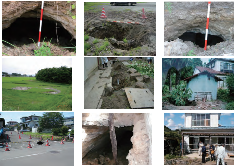
2003年の宮城北部地震による矢本町における陥没被害
