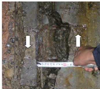
写真 一次覆工の詳細な破損状況
