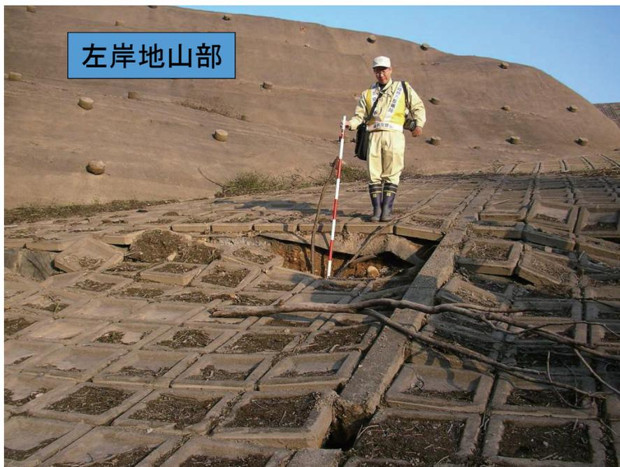
図 川西ダム、左岸崩壊部（下流より見たもの）
