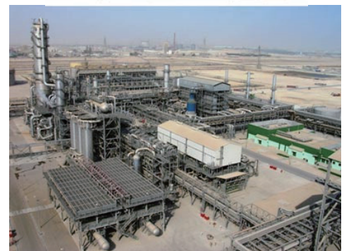
プラントのRC建屋
