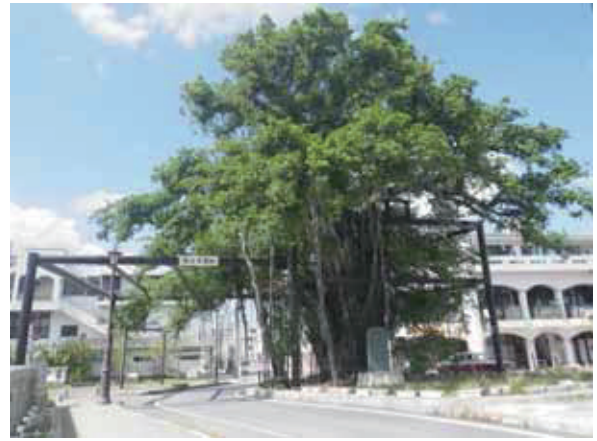
写真-3 倒木対策工 竣工状況
