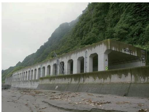
写真-1 RC製ロックシェッドの一例
