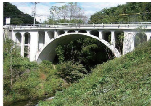
写真-1 現況写真
