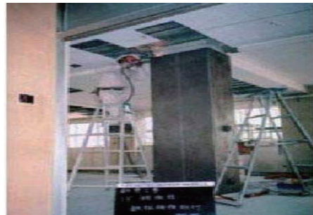
写真－2 鋼板巻き立て工法
